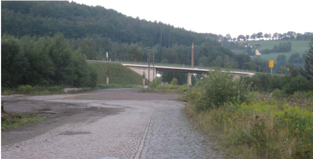
Ladestraße nach dem Rückbau, Blickrichtung Süd-West, in Richtung Brückenbauwerk Ortsumgehung
